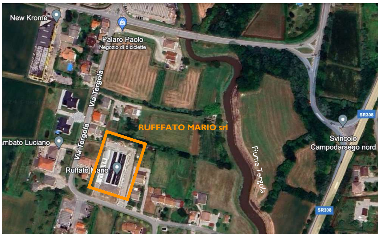
Figura 1: Foto aerea sito Via Tergola 19 CAMPODARSEGO, tratta da Google Maps (agg 2023)
